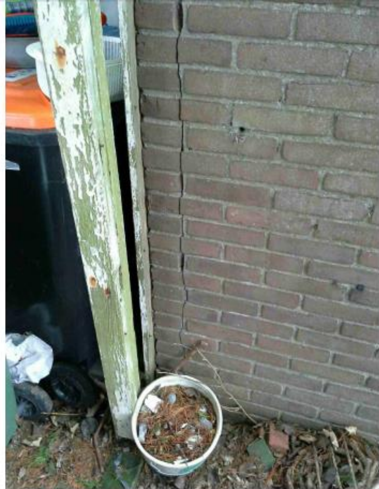
Garage/schuur, Voorgevel: Scheur, (ernstig > 5 mm, verticaal)
